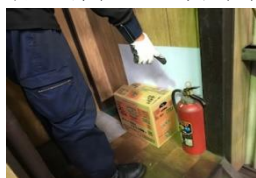
消火器の位置確認
