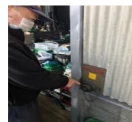
緊急時のシャッター開閉の確認
